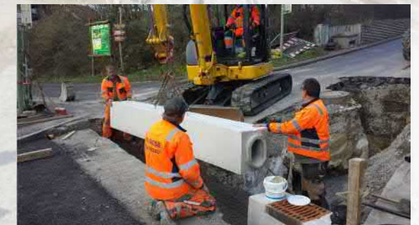
hier Erneuerung Bahnübergang der Lossetalbahn in Kaufungen
