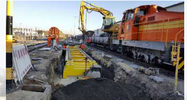
hier Einbau einer Gleiswaage für VW in Baunatal
