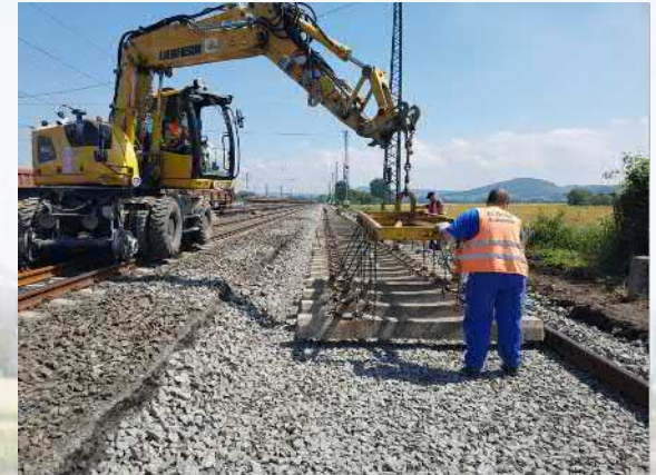
hier Erneuerung der Strecke Kassel-Wabern für die Deutsche Bahn Juli 2018
