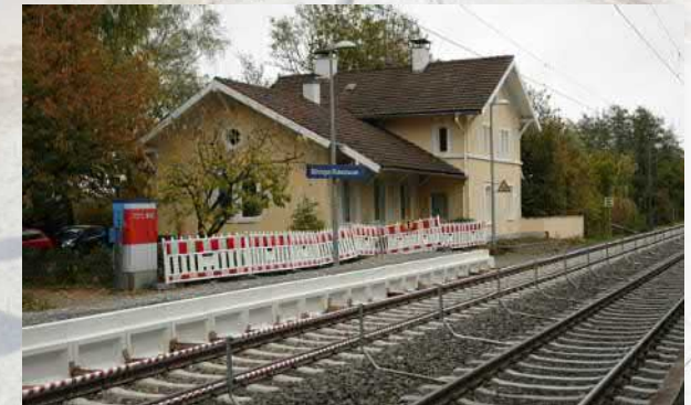
hier Neubau eines Bahnsteiges in Böhringen bei Radolfzell
