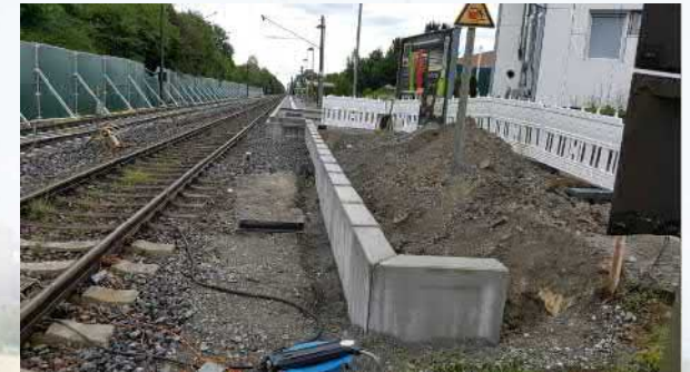
hier Neubau eines Bahnsteiges in Wollmatingen am Bodensee 2017
