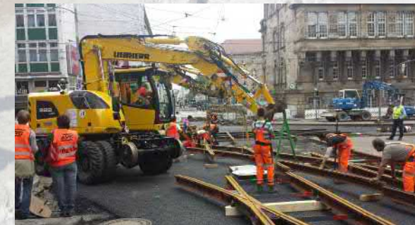
hier Erneuerung der Rathauskreuzung in Kassel Ostern 2016
