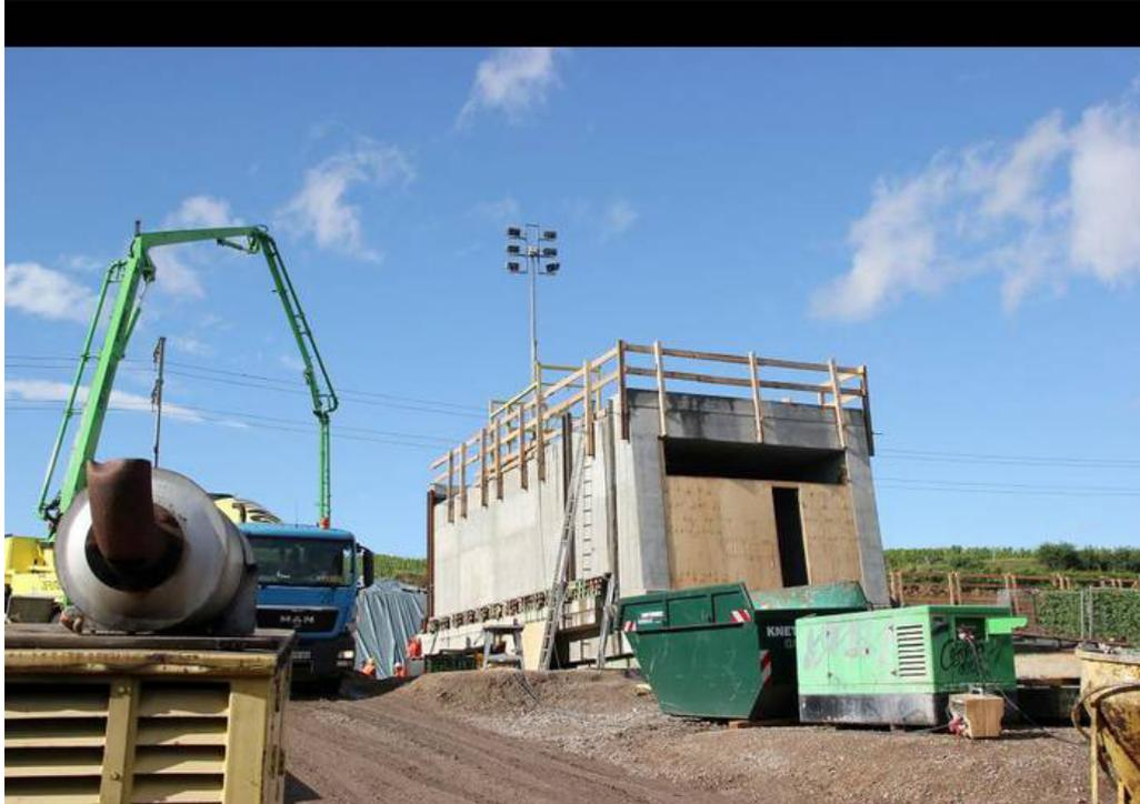
Durch dieses Bauwerk werden die Winzer künftig fahren, um zu Wingerten zu gelangen. Die Eisenbahnunterführung ist schon fertig gebaut und wird später in den Damm „eingeschoben“.
