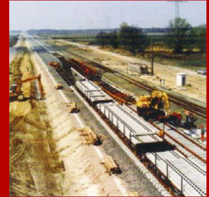
Neubau Schnellbaustrecke mit UWG. Montage der „Joche“
