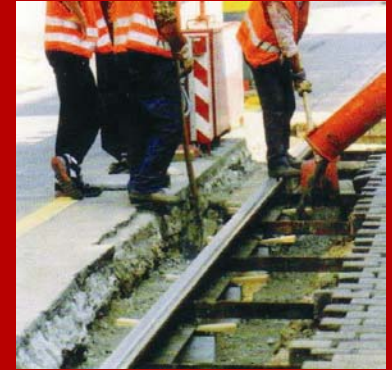
Rillenschiene RI 60 N ausgerichtet Unterfütterung mit Beton B 25, Körnung 0/16
